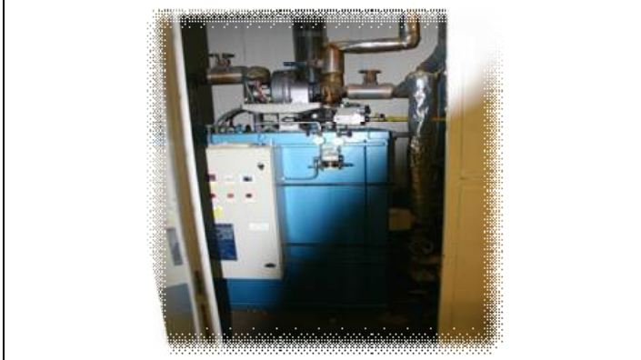
kotelna - ohřev oleje pro fritézu
